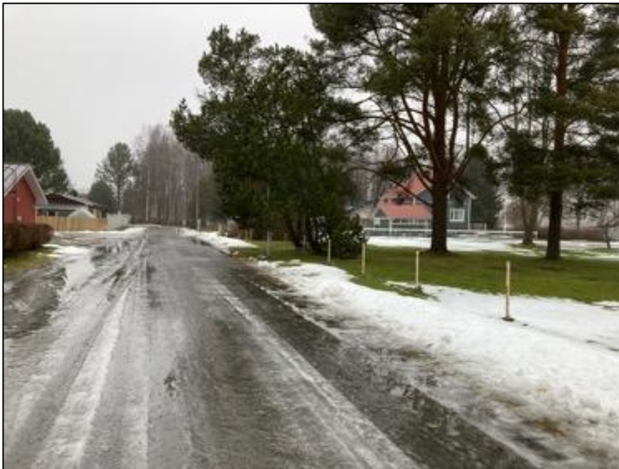
Katiskantie kaavamuutosalueen kohdalla
